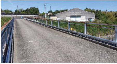
伊勢自動車道横断橋添架水管橋更新工事
