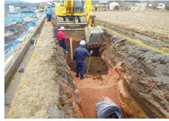
1号幹線水路本管布設替え工事
