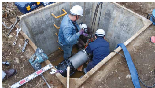
流量計の更新（長谷山支線）
