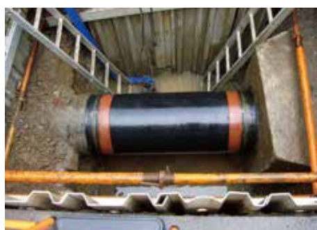
漏水箇所の補修（中支線φ600mm 2箇所）
