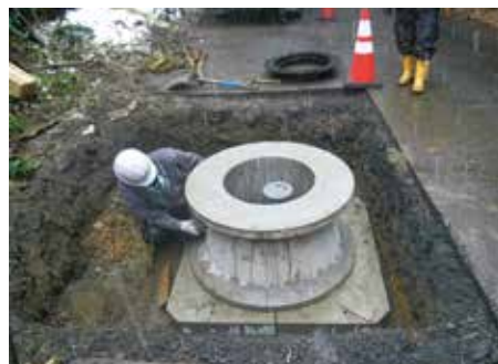
空気弁の更新（中支線 5箇所）
