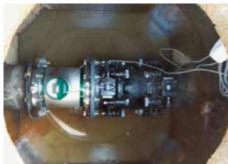
流量計の更新（上野支線 2箇所）
