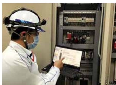
水管理システムの保守点検
