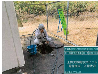
通信ケーブルの更新（適正化事業）
