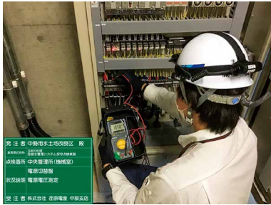
水管理システムの保守点検
