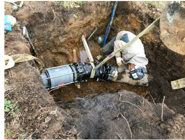
管水路の漏水補修
