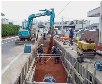
【中勢用水1期地区】安濃工業団地内
