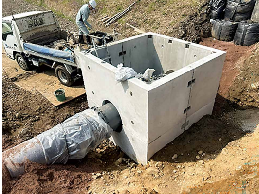
【中勢用水1期地区】1号幹線水路更新工事
