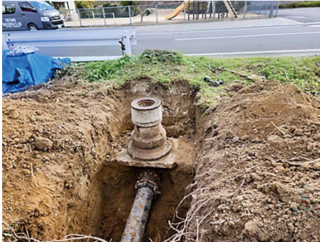
仕切弁（バルブ）の更新工事
