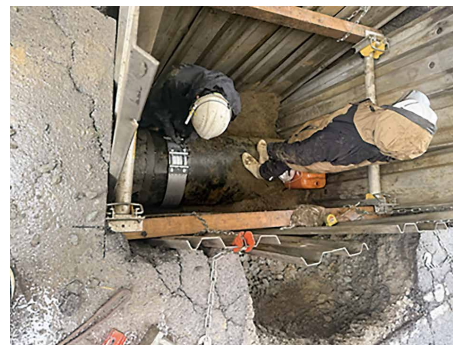
漏水発生時の様子と復旧工事
