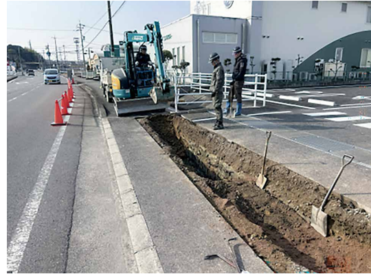
【中勢用水2期地区】中支線水路更新工事
