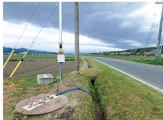
古井戸への仮設ポンプ設置
