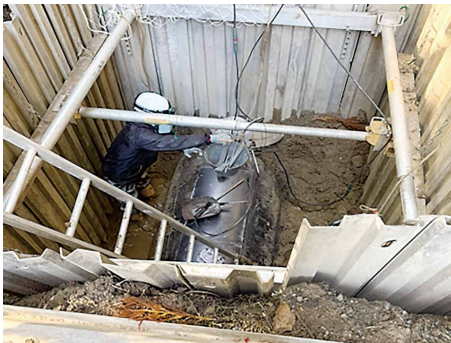
漏水箇所の修繕
