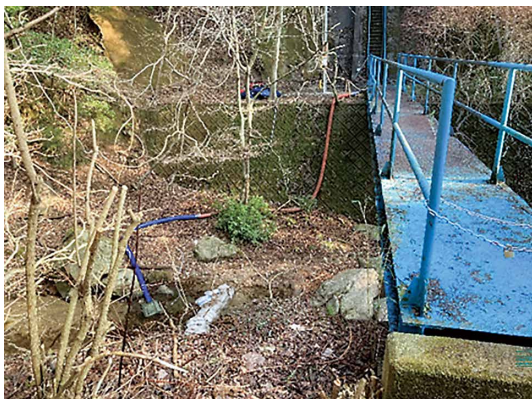
小河川への仮設ポンプ設置
