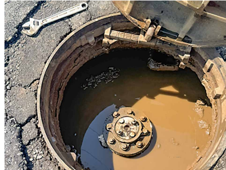
水漏れする空気弁の整備
