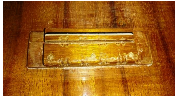
補強材打ち込み接着完了
