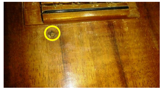
配線通し穴埋め木
