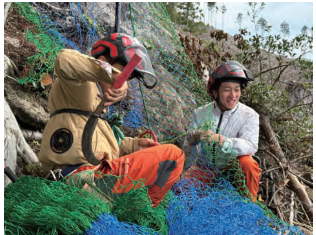
獣害防護柵の網張り作業の様子
