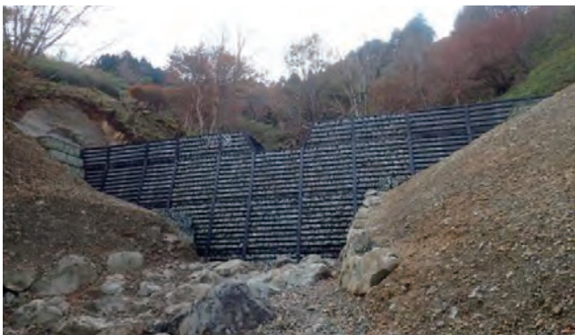
鋼製谷止工(令和5年度施工)
