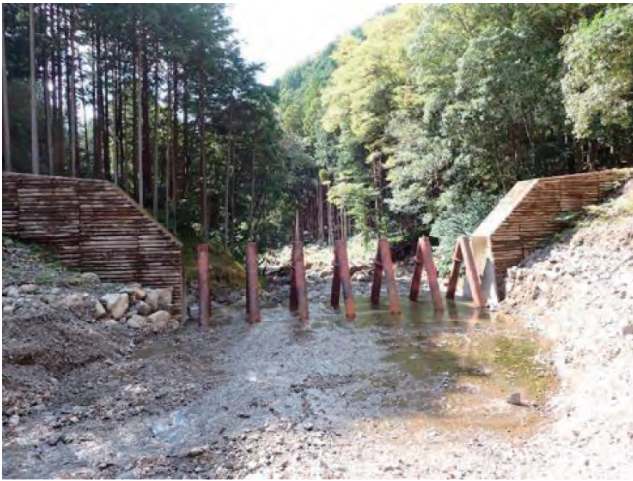
流木や土砂の流下を防ぐスリット谷止
