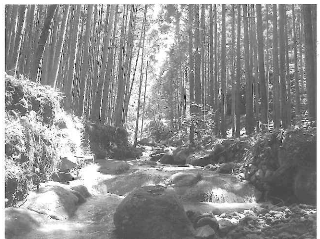
紀宝町（大地山）整備後
