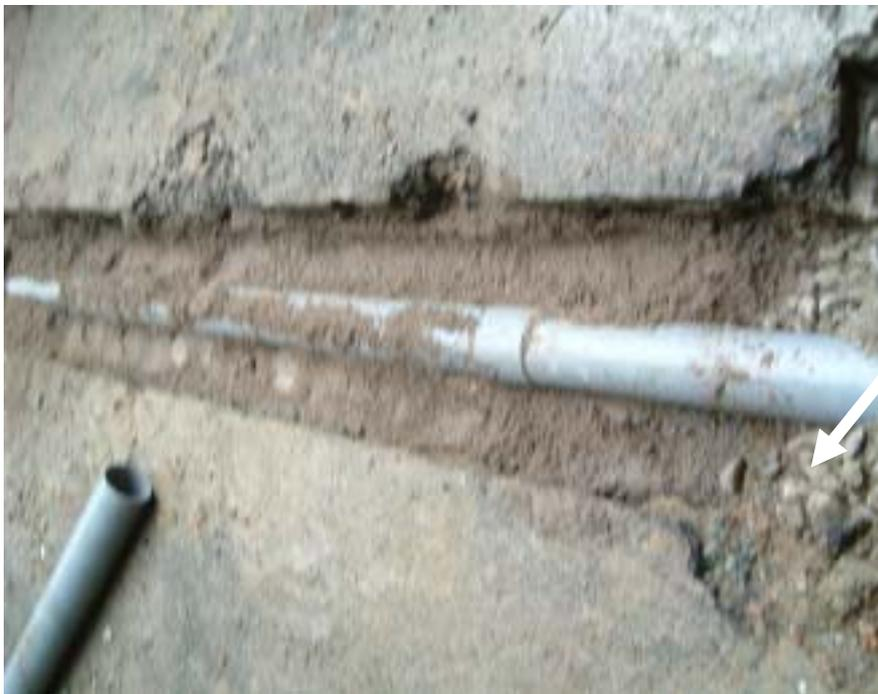
写真の様に管の周りは砂にて埋設して居ります。
