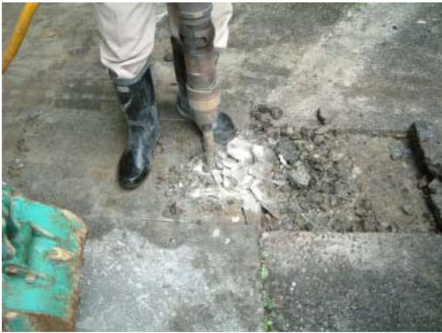
削岩機にてハツリを行い、それらを掘削機にて掘り起こして行きます。
