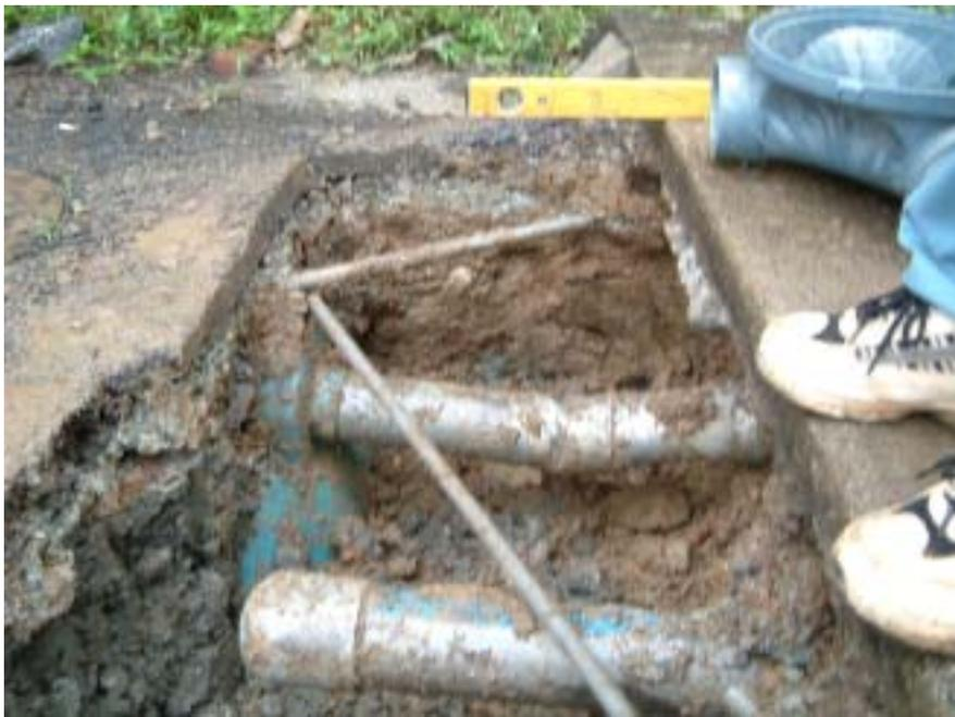
既存の浄化槽への接続を行うに付き、現状の流入口の様子を伺います。
