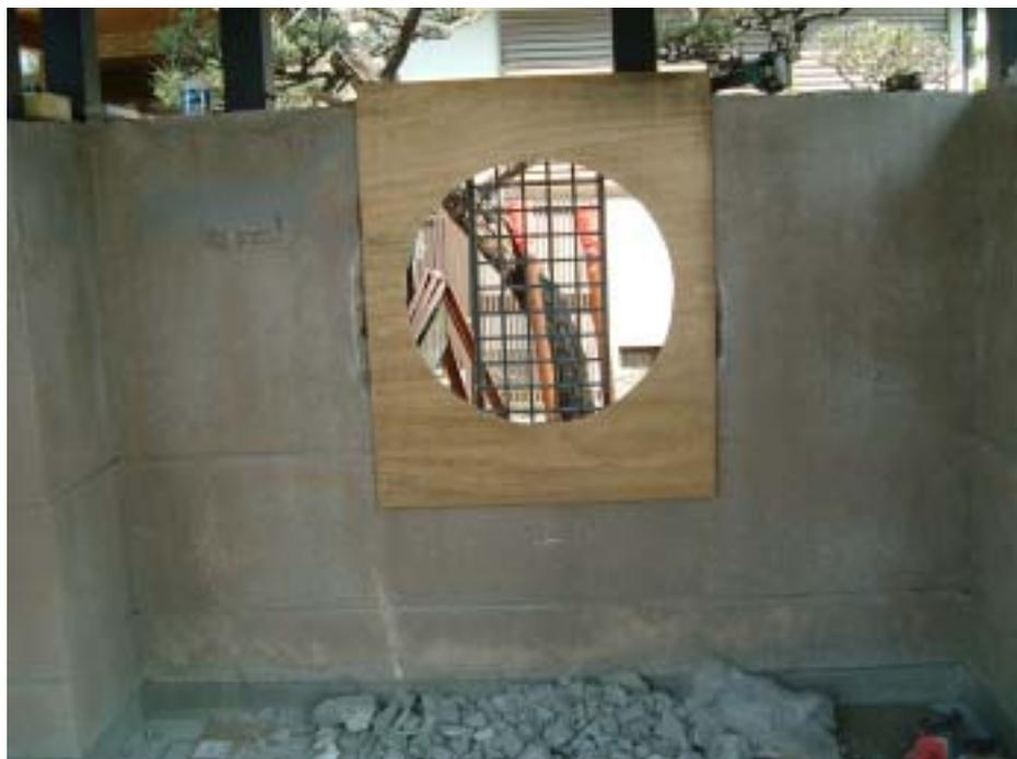
丸窓はアルミ製のフィックス型フェンスを入れ込み、縦の強度を持たせています。
